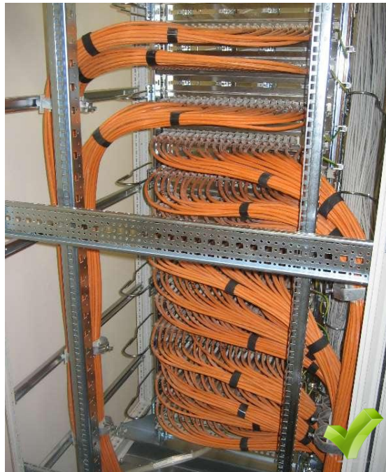
Abbildung 5: Seitliche Verlegung und Zuführung der Kabel innerhalb eines IT Schrankes
