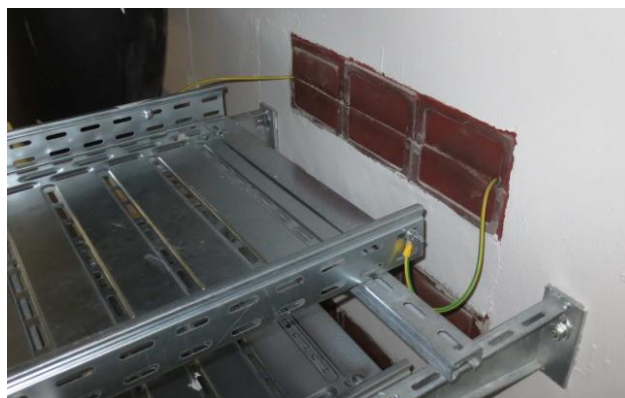
Abbildung 19: Unterbrechung metallener Kabelführungssysteme an Brandschutzmauer
