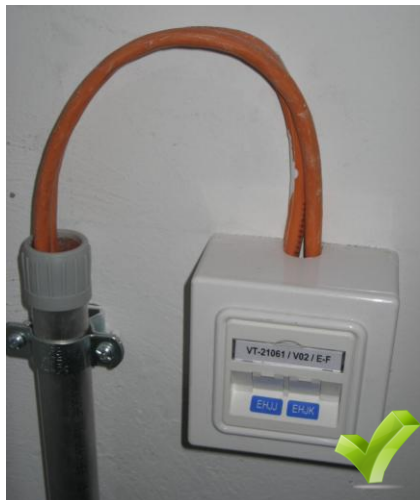
Abbildung 1: Biegung der Kabel ohne Beeinträchtigung
